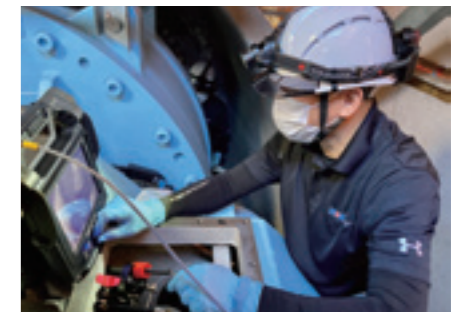
風力発電所/ボアスコープ調査
