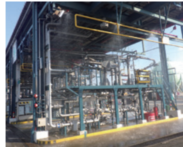
ローリー積場フォームヘッドから放水
