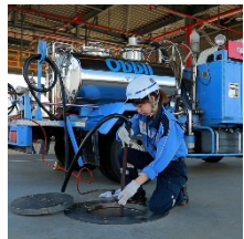
給油設備の点検業務
