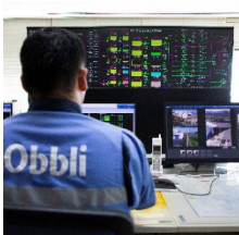
コントロールルームでの監視業務
